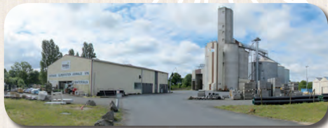
Site de Terrena Poitou à Saint-Varent - J. Rovira
