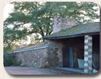
Four de la tuilerie-briqueterie à Glénay
