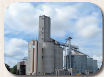
Les silos du site Terrena Poitou de Saint-Varent
