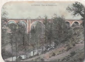
Le Viaduc de Conquenuche - Coll. P. Auger
